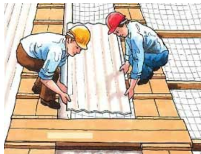
Immagine 5 e 6 Uso di reti di sicurezza temporanee per rifacimenti e manutenzioni coperture
