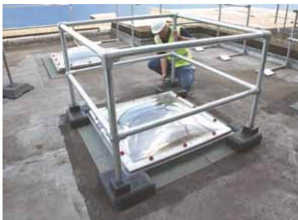
Immagine 9 Parapetti perimetrali a zone a rischio sprofondamento
