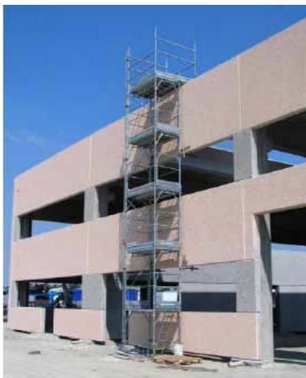
Immagine 2 Esempio di accesso provvisorio sicuro mediante torre di ponteggio
