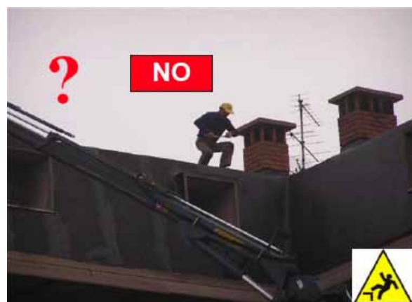
Immagine 1 lavorazione in copertura senza alcuna misura protettiva
