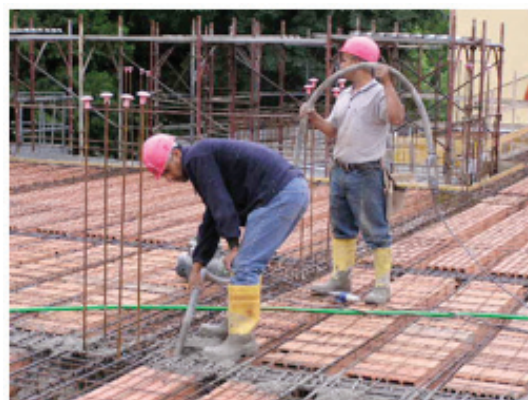
Immagine 24 getto con successiva vibrazione del cls
