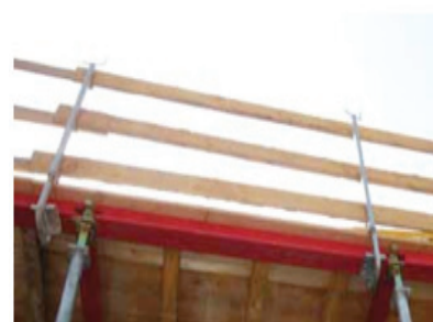
Immagine 21 parapetto perimetrale
