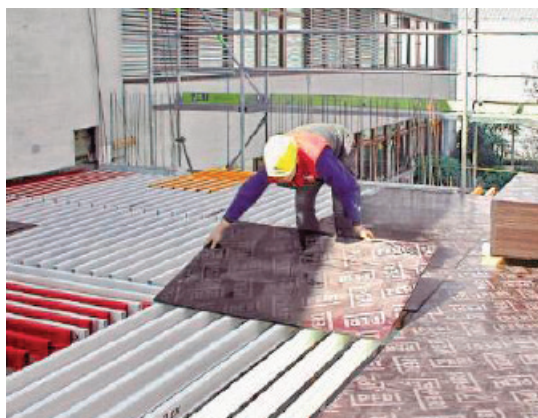
Immagine 10 - 11 Posa pannello su cassaforma Gridflex previo montaggio specifici parapetti o ponteggio laterali
