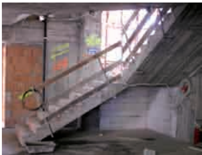
Immagine 03 e 04 Uso parapetto prefabbricato metallico del tipo "a vitone"
