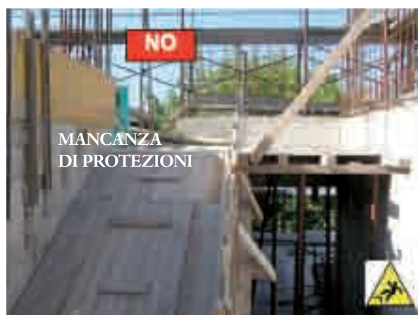
Immagine 01 assito scala in costruzione
