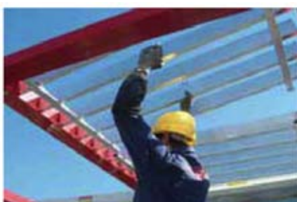
Immagine 11, 12 e 13 Utilizzo casseformi industriali (grigliato leggero) per posa travi e solai
