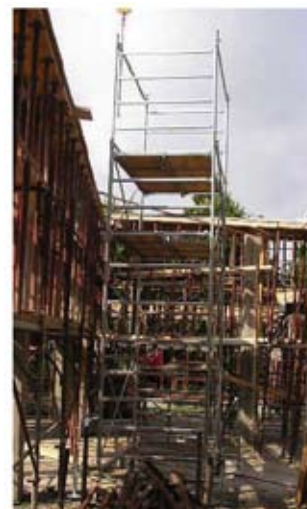
Immagine 08, 09 trabattelli da usare per la posa di pilastri e travi: UNI HD 1004
