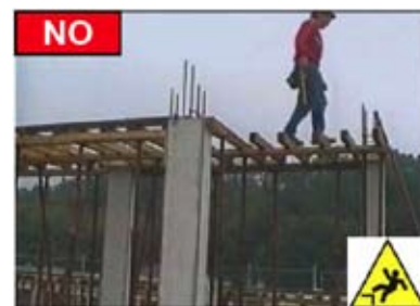
Immagine 03 Camminamento sui travetti banchinaggio trave senza protezioni
