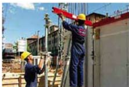
Immagine 11, 12 e 13 Utilizzo casseformi industriali (grigliato leggero) per posa travi e solai
