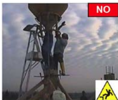
Immagine 04 Evitare getto pilastro, con uomo in quota sulle "cravatte"
