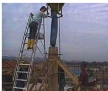
Immagine 05 Nell'uso delle scale a castello privilegiare quelle di altezza adatta alla lavorazione
